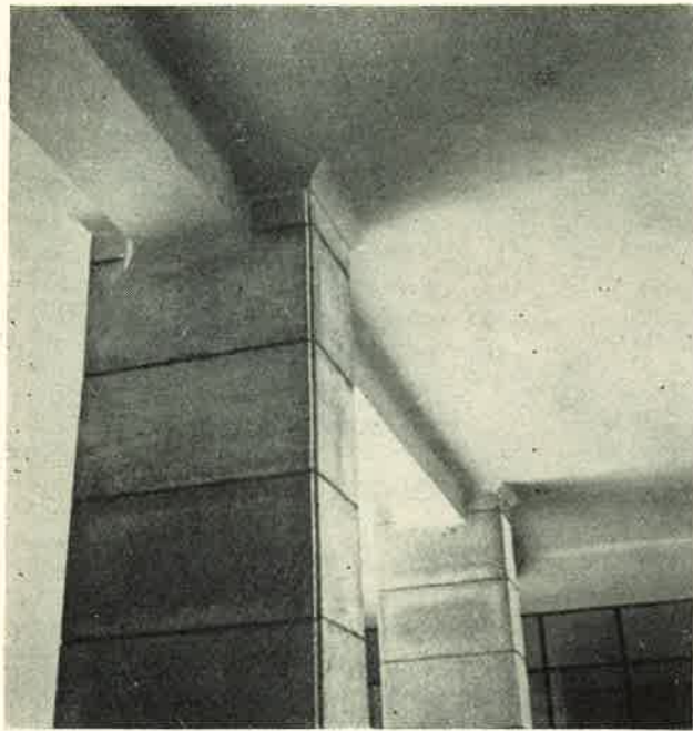
33. Terméskőburkolatú pillérbe metsződő födémbordák a kocsihajtóban.
