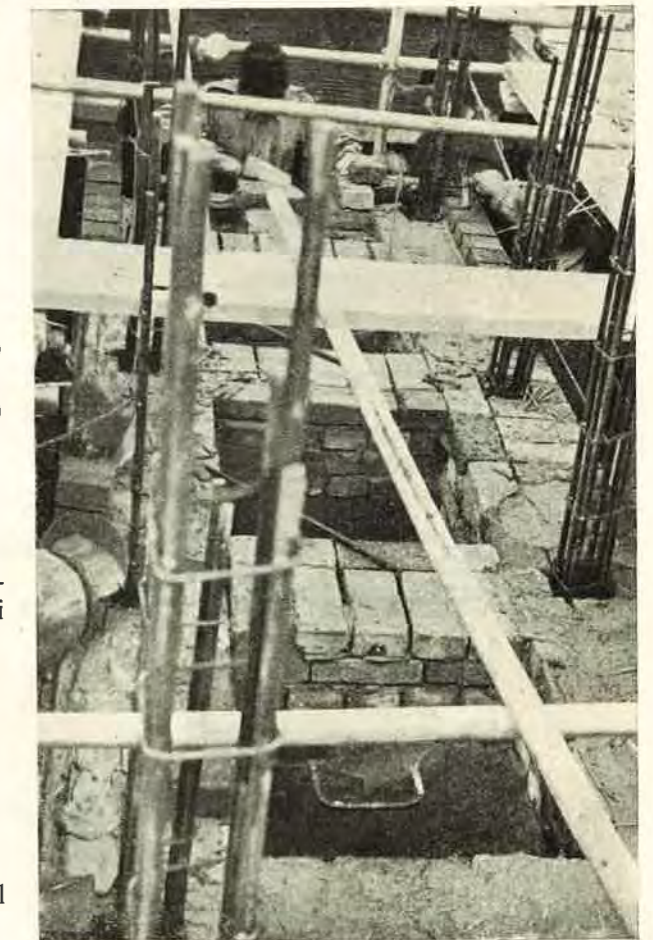
7. ábra. Vasalt kéménypillér falazása és vasalása
