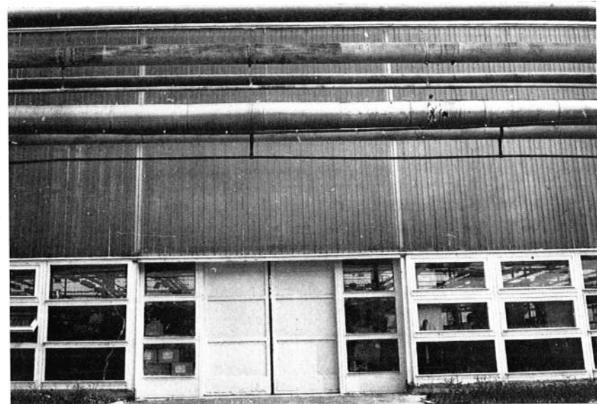
Csarnok szerelő bejárat
