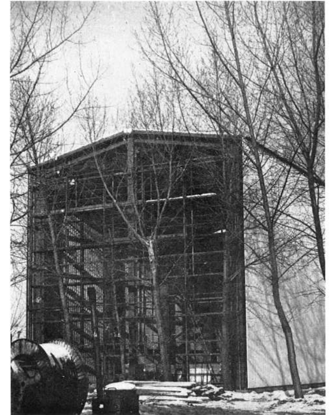
A raktár építés közben
