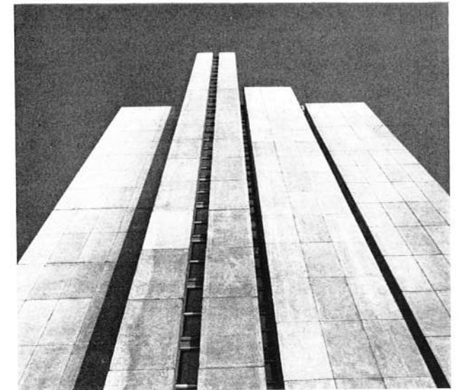
A toronyépület nyugati, előregyártott vb. paneles homlokzata
