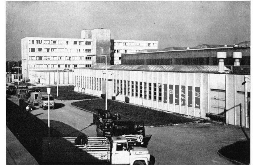
A műhelycsarnok homlokzati részlete
