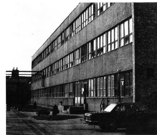
Szociális-iroda épület homlokzata
