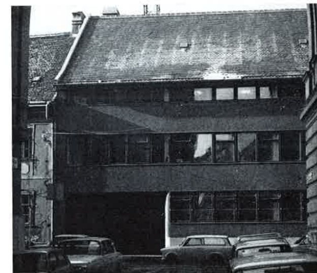
Iskola u. 16. laboratórium homlokzata
