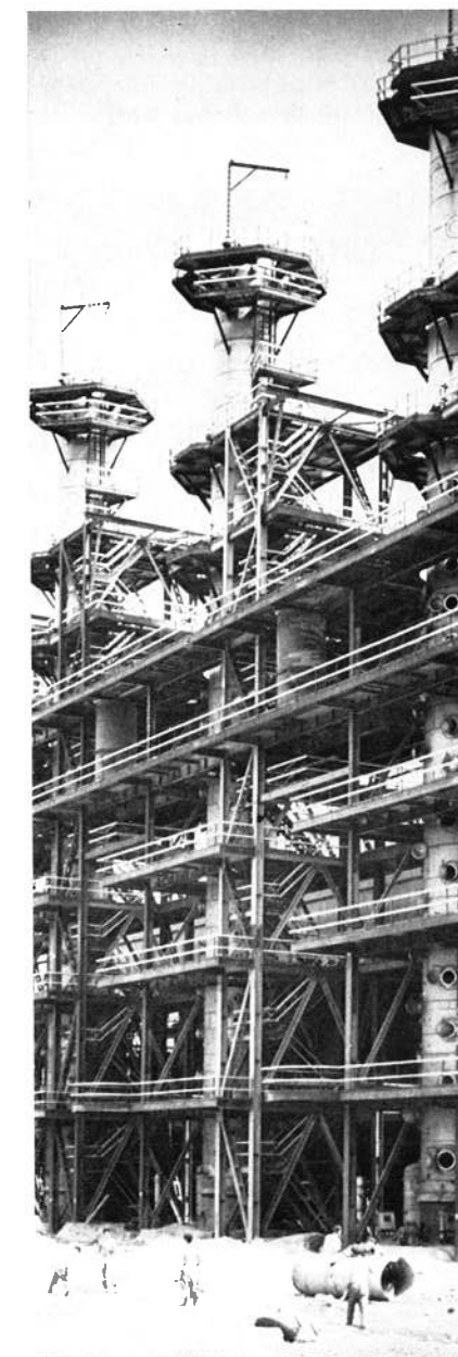
Savüzem technológiai tornyok acélszerkezete
