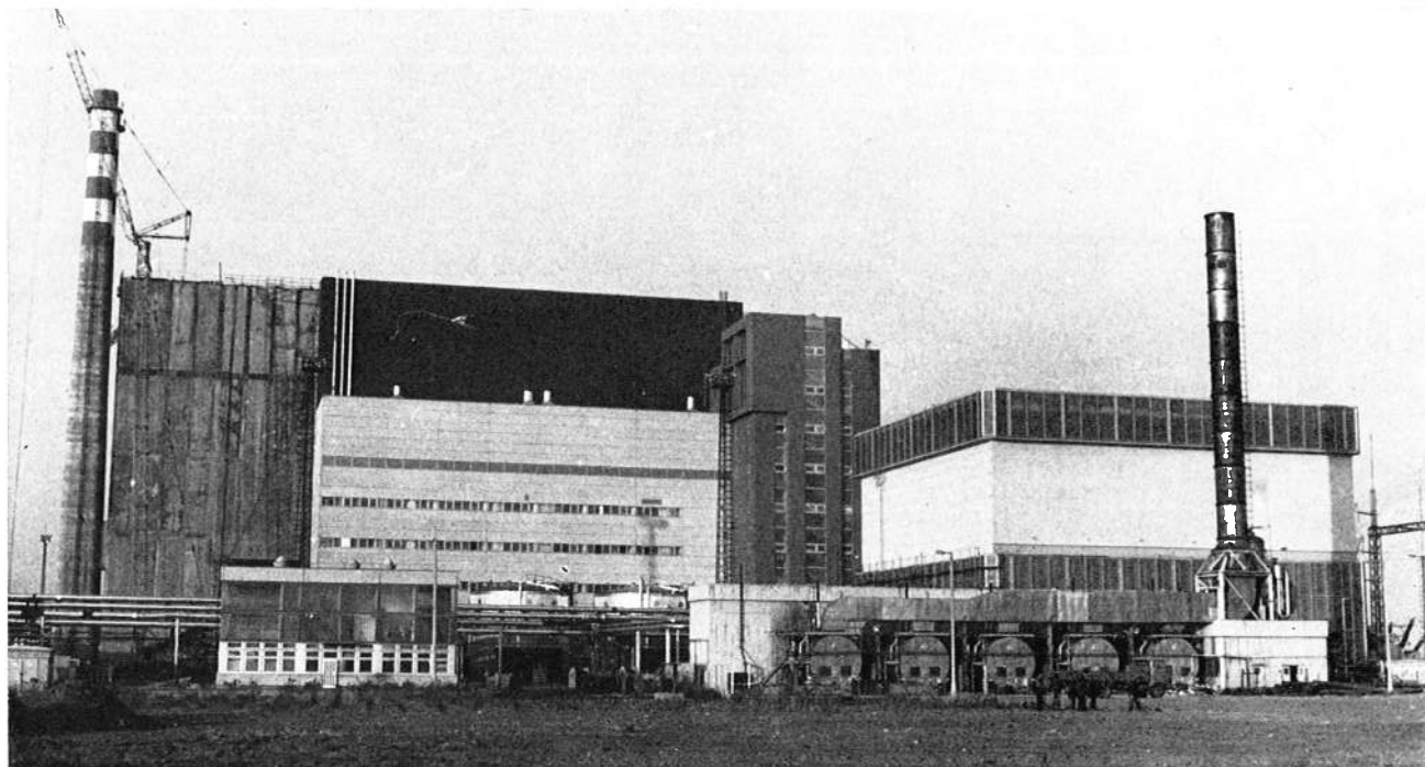
Keresztirányú villamos terek felőli homlokzat (Foto: Deák Hunor MÉLYÉPTEKV)
