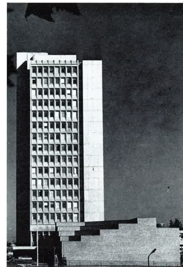
A székház épület homlokzata a soroksári Dunaág felől
