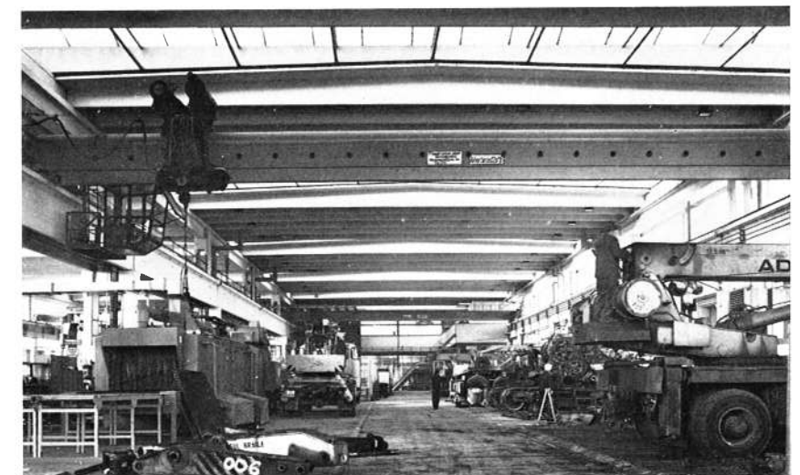
A javító csarnok belső képe
