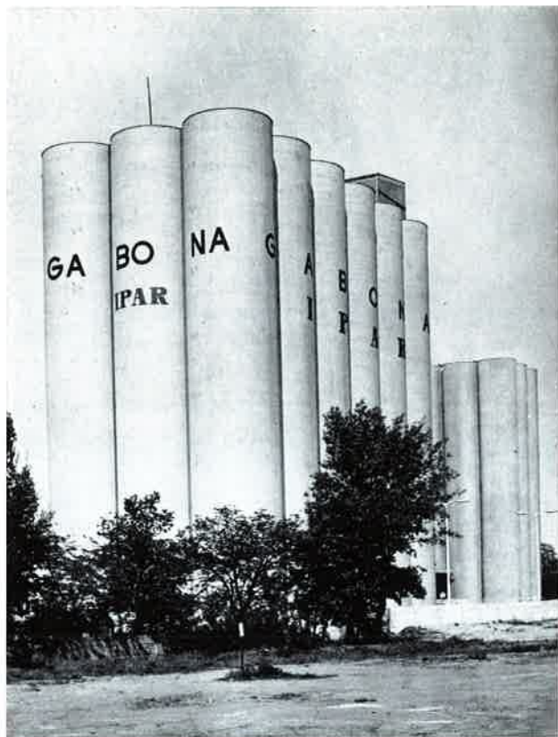
Törökszentmiklósi 21 000 tonna befogadóképességű gabonasiló, mellette a korábban épült 8400 tonnás gabonasiló
