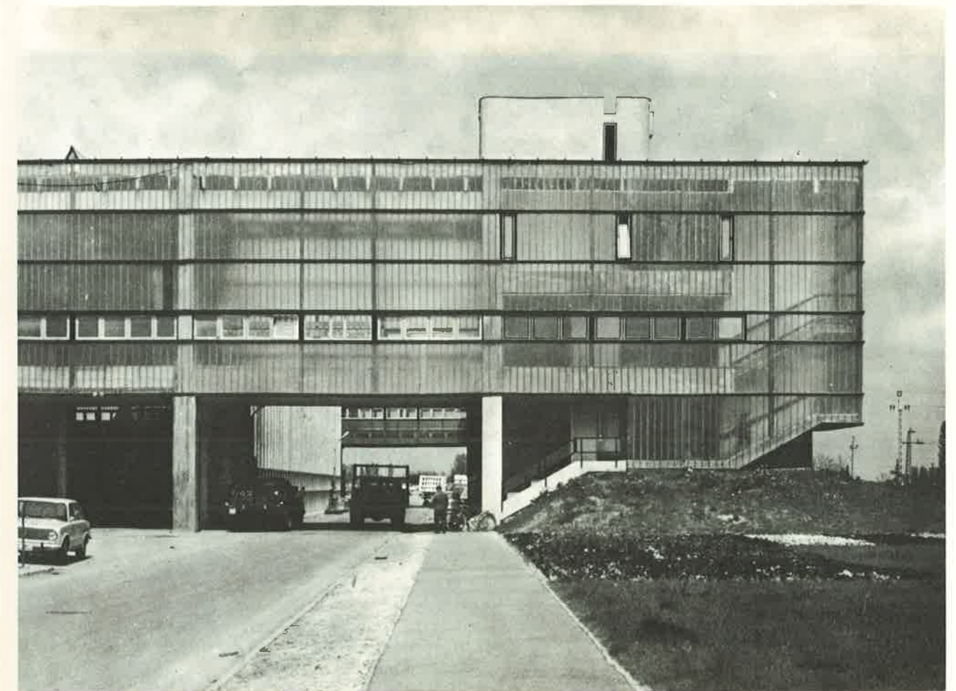
Fejépület és üzemi épület csatlakozása
