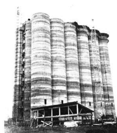
Törökszentmiklósi 2000 v-os siló a csúszás befejezése után.
