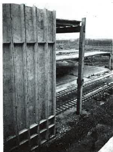
Csomagoló épület szerkezete építés közben a 14 m magas falpanelelkel
