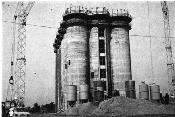
A jászberényi 2000 v-os siló építés közben. Az előtérben látható a betonüzem,
