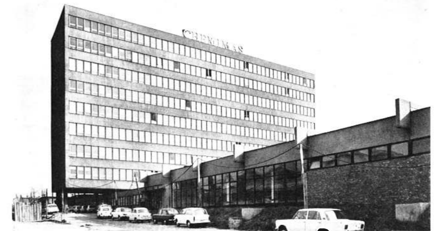
Noszlopi utcai homlokzat
