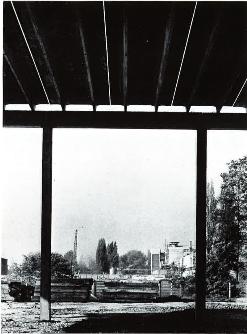
A csarnok vázszerkezete a feszítettbeton tetőpanelekkel
