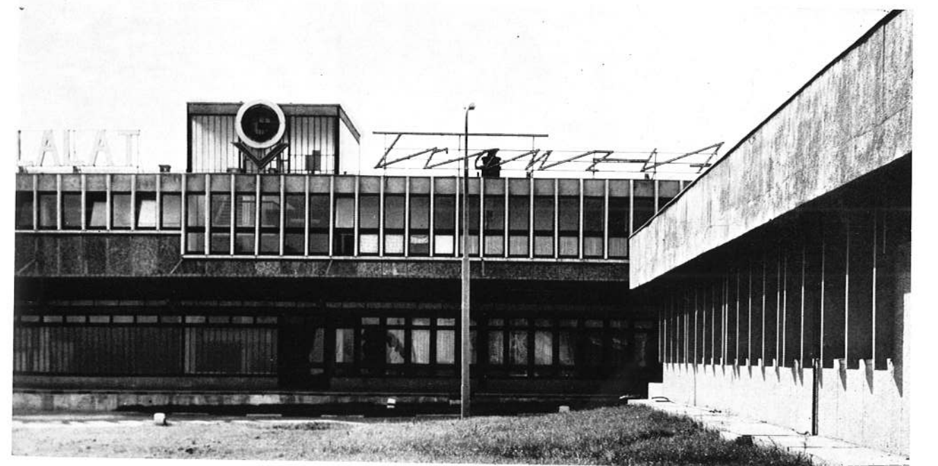
Főhomlokzati részlet a porta felől
