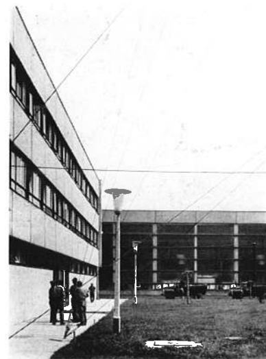
Iroda és gyártócsarnok, homlokzati részlet a bejárat felől
