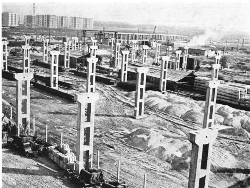
Ferencvárosi házgyár gyártócsarnok előregyártott pilléreinek állítása
