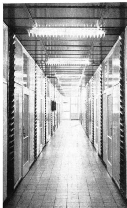
Folyosó részlete a hátoldali szerelő aknákkal
