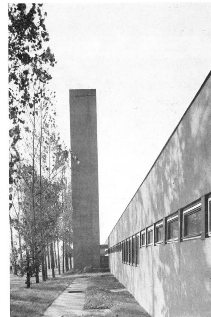
B épület (hajtatóház) oldalhomlokzati részlete
