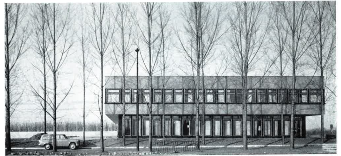
Iroda, laboratórium (C épület) déli homlokzata
