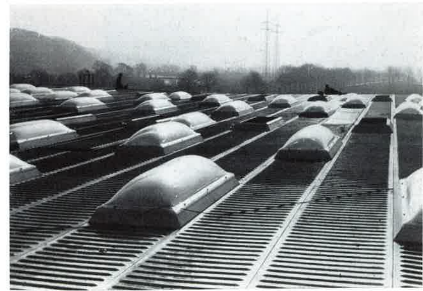
14. A kész tető felülnézete a szerelés befejezésekor. A tető semmiféle járulékos tetőhéjalást nem igényel. A műnyaggal bevont lemezek egy elemmel megoldják a teherhordó szerkezet és az időjárásálló tetőhéjalás feladatát
