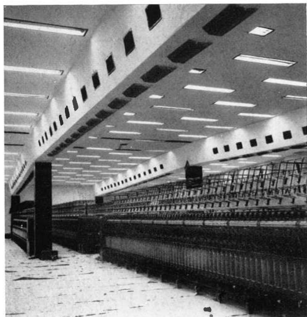
Textilcsarnok belső képe
