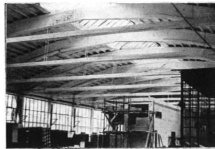
1. Feszített vasbeton ívtartó
