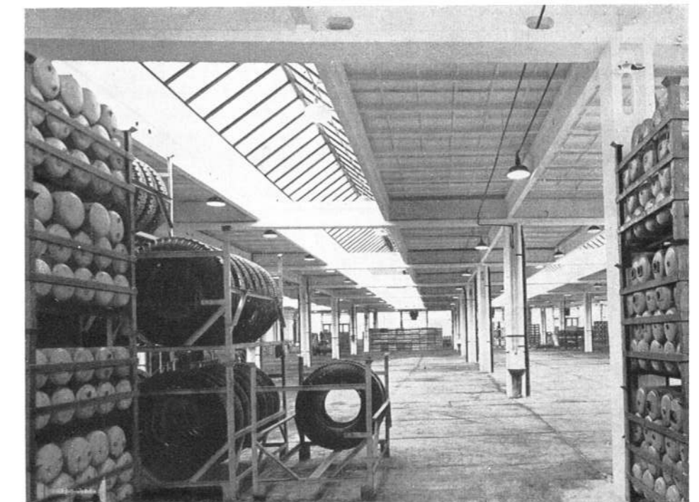
Csepel Autógyárban épülő többcélú üzemi csarnok üzemen előregyártott vb. szerkezeti váza és falpaneellekkel
