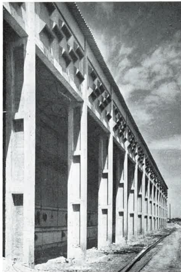
Nyersanyagtároló fogazósín, homlokzat
