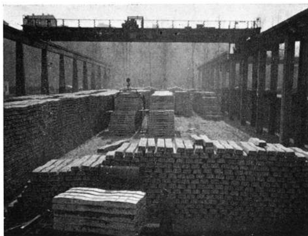
12. Feszített betonlapok korszerű tárolása Látatlanon futódaruk segítségével
