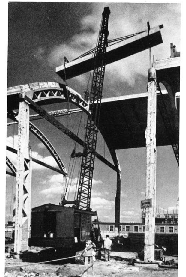
Kovácsüzem tetőpaneljeinek beemelése
