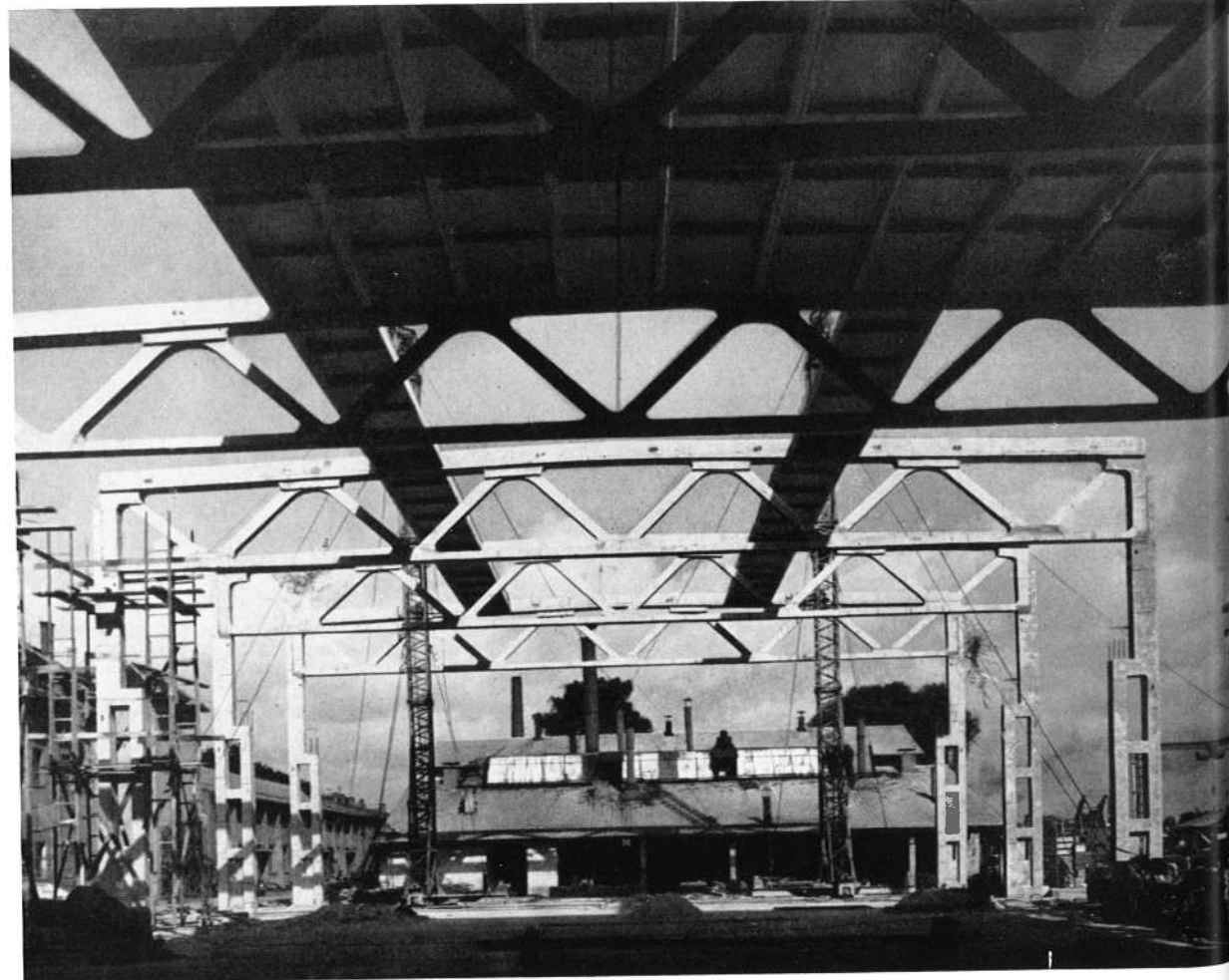
A tetőpanelek elhelyezése
