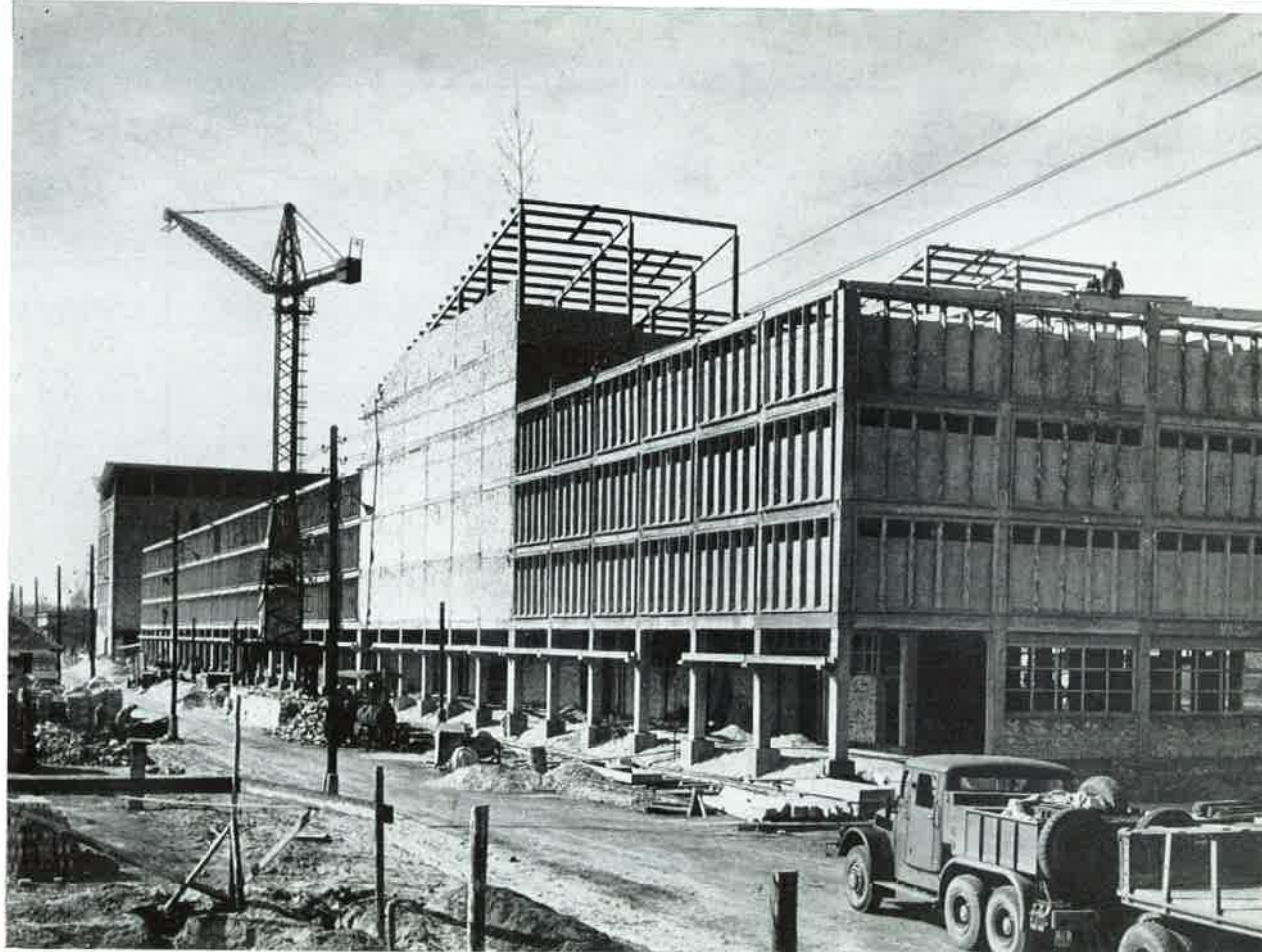
A tárház építés közben
