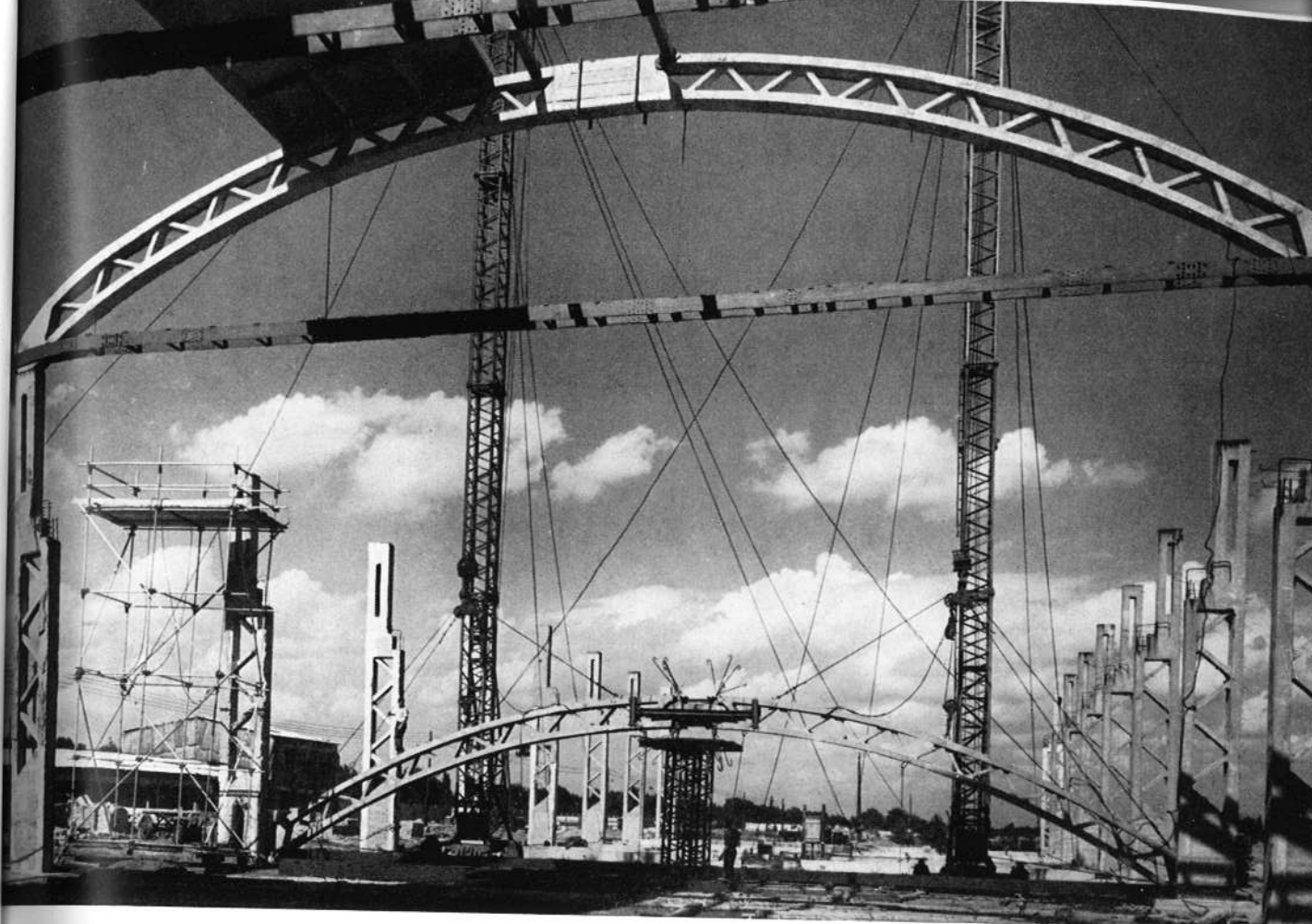
Kovácsüzem rácsosív szerkezetének beemelése
