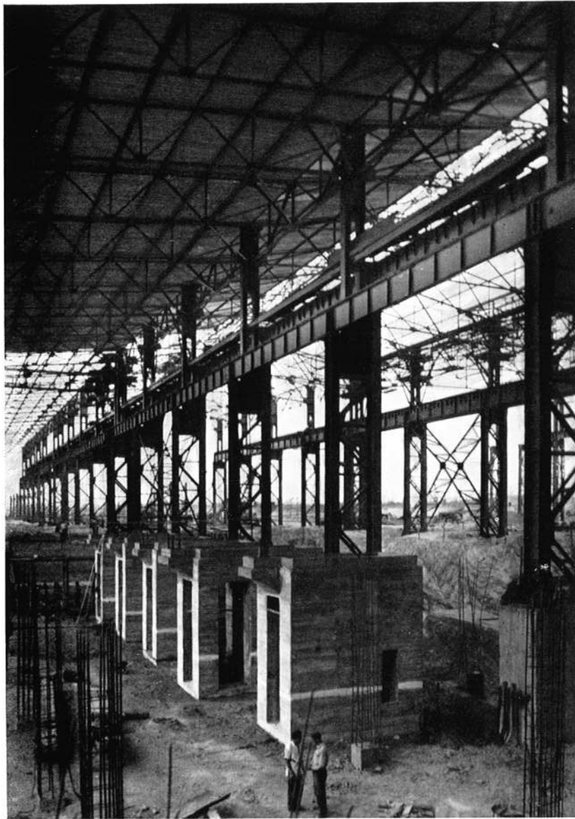
Gépalapok a 2. számú gépteremben
