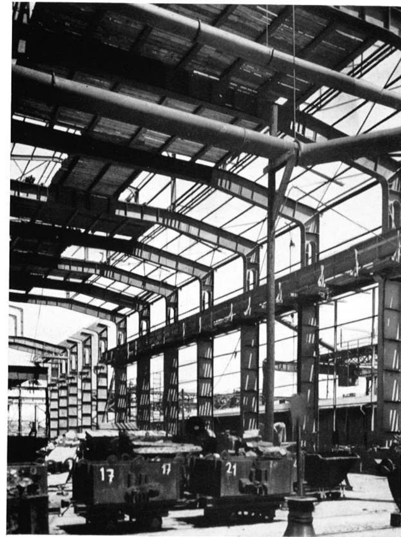
Az asbesztcement tetőelemek elhelyezése
