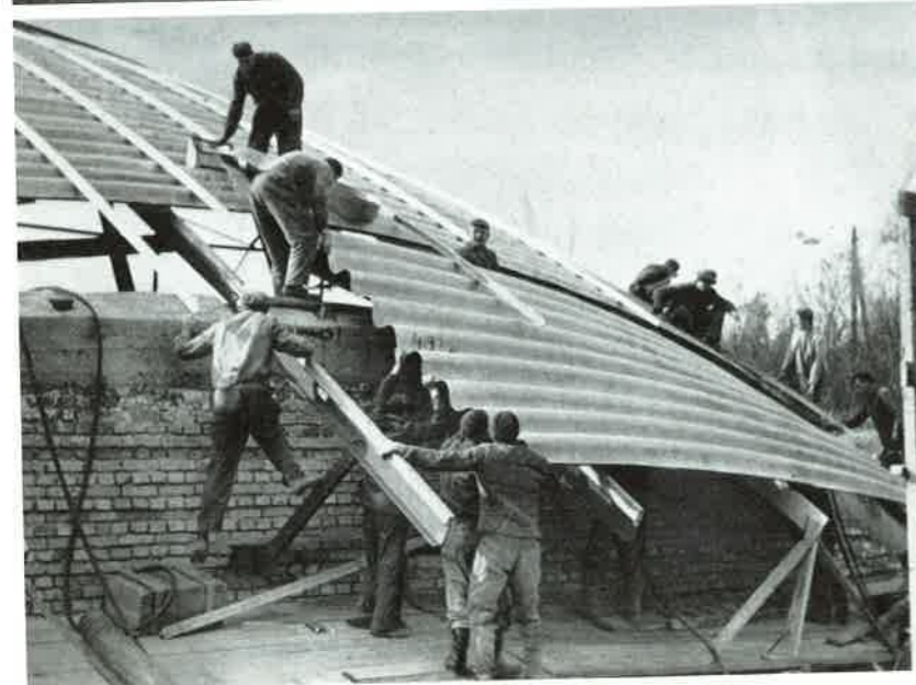
Alumínium hullámlemezek illesztése
