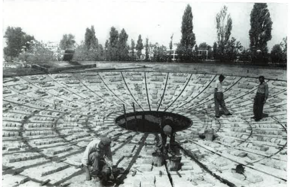
Tetőfelület előterhelése és előregyártott vasbeton tetőelemek közötti hézagok utólagos betonozása
