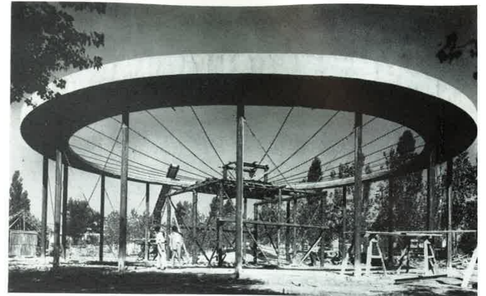
A Pavilon építés közben a peremgerenda elkészülte után
