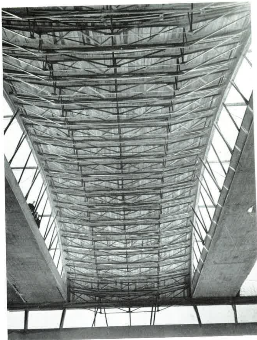
A héjszaluzat csarnok felőli képe
