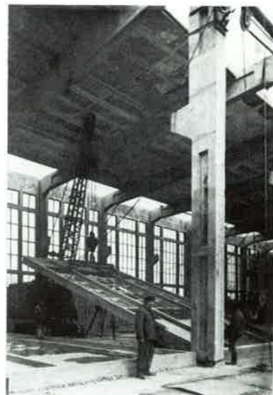
Falpanel felállítása hernyótalpas daruval és csörlő berendezéssel
