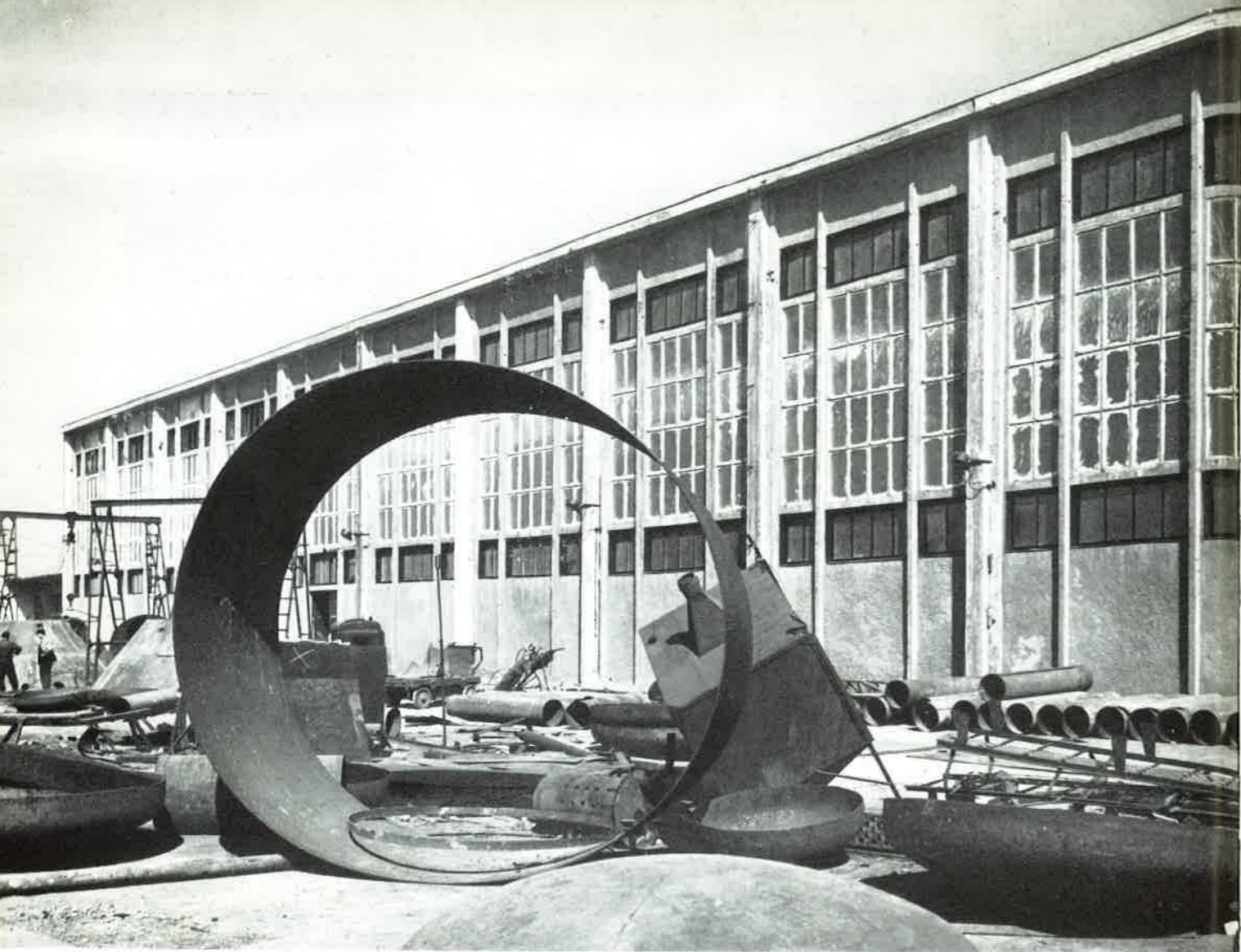
Csarnok homlokzata építés közben
