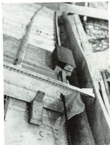
Peremgerenda és hullámlemez csatlakozása
