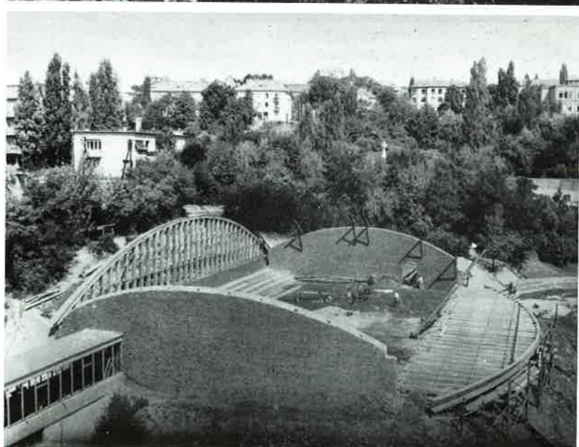
A részben felhúzott tetőszerkezet Homlokzati falbeemelés Lefektetett homlokzati fal
