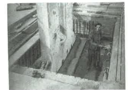
Az alap képe az elhelyezett oszlop betonozása előtt
