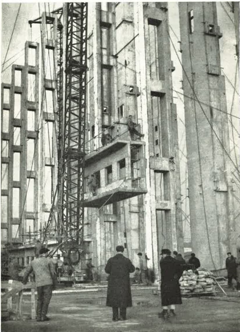
Felállított Vierendeel szerkezetű csőpillérek és többrendeltetésű csőtartó emelése.
