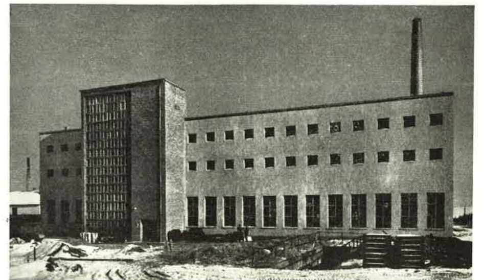
Az irodaszárny homlokzata építés közben
