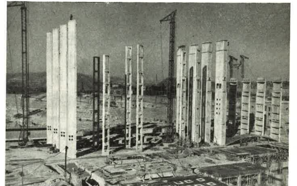
Panel elemek és csőpillérek felállítása
