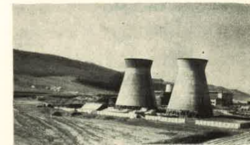
12. ábra. Kettős kúp alakú hűtőtorny
