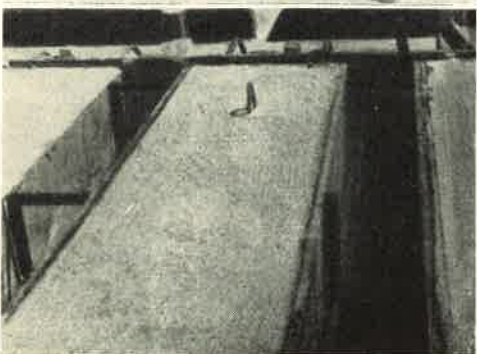
Mestergerendák zsaluzata. A láblák egymáshoz való merevítését a képen látható fémkapcsok szolgálják
