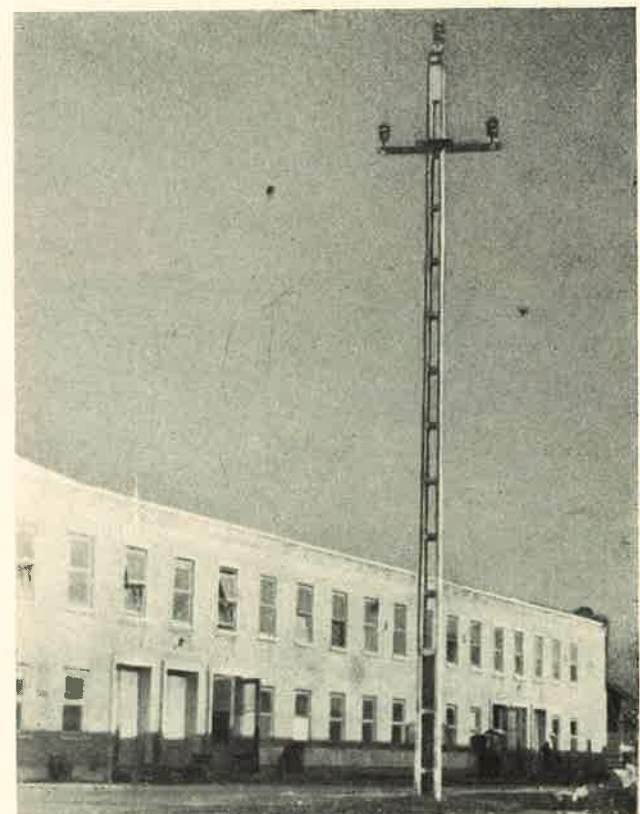
9. ábra. Előfeszített tartó négyzetes perforálással
