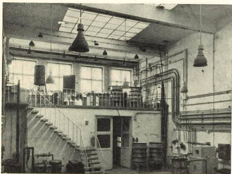
8. ábra. Veszprémi Vegyipari Egyetem „D” épülete. Belső kép
