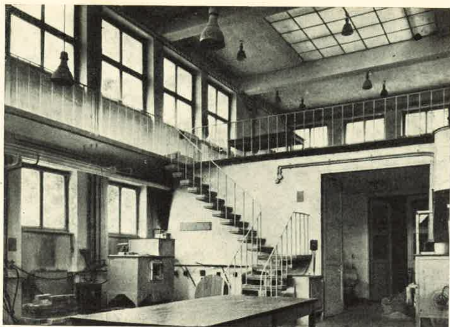
7. ábra. Veszprémi Vegyipari Egyetem „D” épülete. Belső kép
