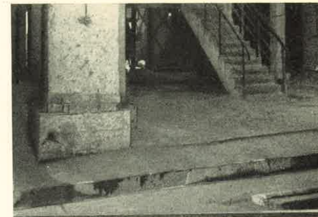
15. ábra. Kénsavüzemben új padlóborítás és új csatornák készítése
