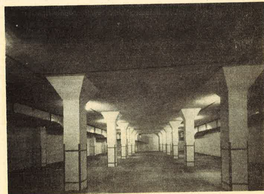
6. ábra A Győri Hűtőház 0\text{ C}^\circ -os terme. Jól megfigyelhető a terem hosszoldalán végigfutó facsatornák elhelyezése (Magyar Foto)
