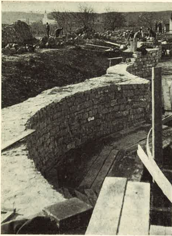
10. ábra. Balatonfüredi pince építés közben. Pincezáró támfalak
