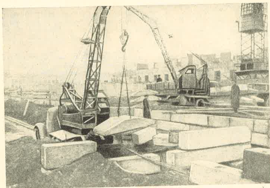
1. ábra Nagyblokkokból álló alap szerelése gépkocsidarukkal a J. V. Sztálin sugár-úton, az egyik lakóház építésénél
