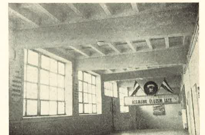
11. ábra. Blokkolófolyosó belső nézet
