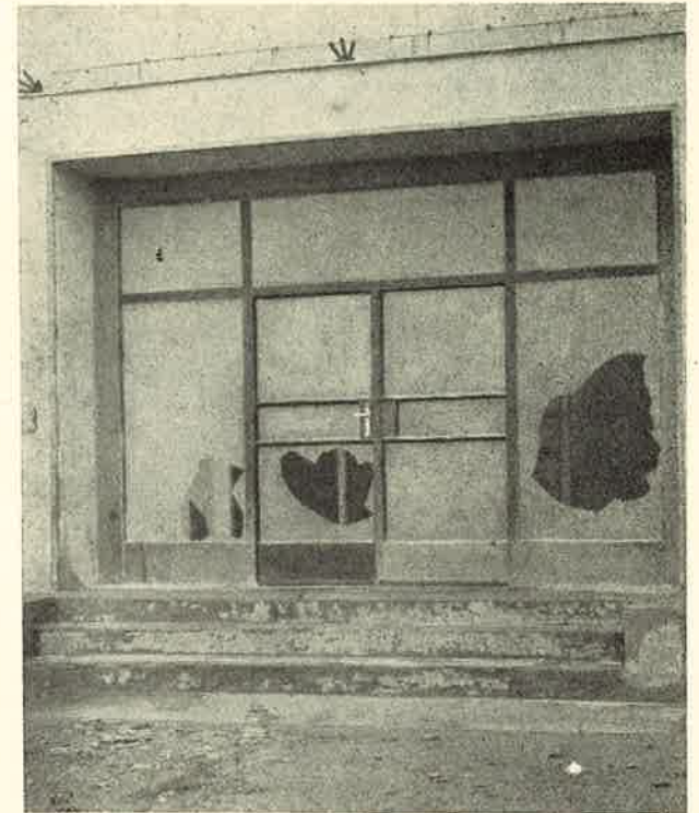
18. ábra. Mélyen üvegezett vasajtók üvegvédelem nélkül
