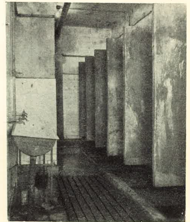
24. ábra. Sz. V. Regieüzem zuhanyozók A válaszfalak magassága túlzott (2,20 m) célszerű magassága 1,80 m.
