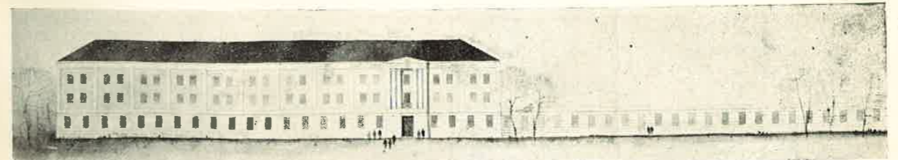
Homlokzat az út felől
