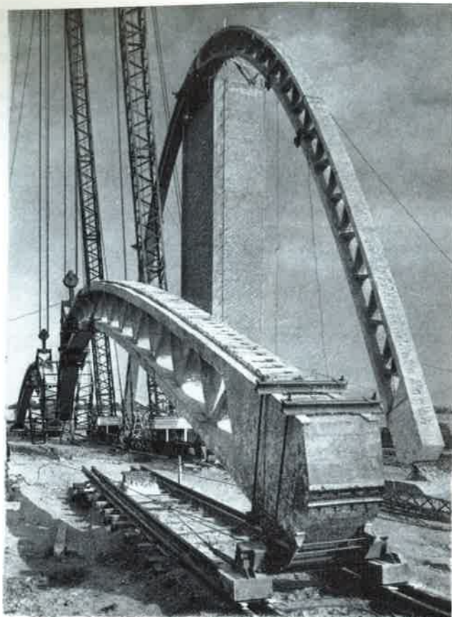
1. ábra. A kazincbarcikai műtrágyaraktár íveinek emelése emelő-kétlábakkal (Gnädig Miklós)
