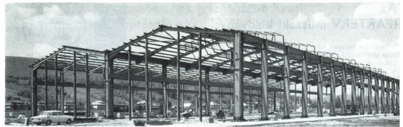
1. ábra. SKÜ gyártócsarnok CONDER szerkezete, Kisterenye
