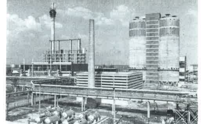
3. ábra. TVK salétromsav-üzem, abszorpciós tornyok és szórótorny
