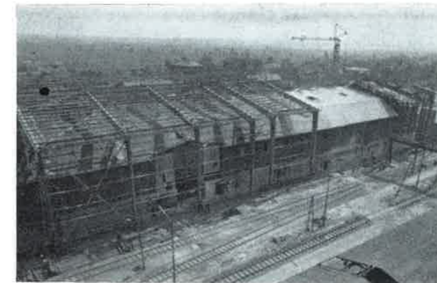
4. ábra. Faszervezetű csarnok újjáépítése acélszerkezettel, Peregmaraton
