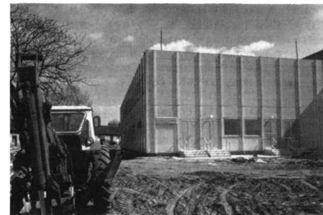
7. ábra. FILLOD szerkezetű üzemi irodaépület, Budapest
