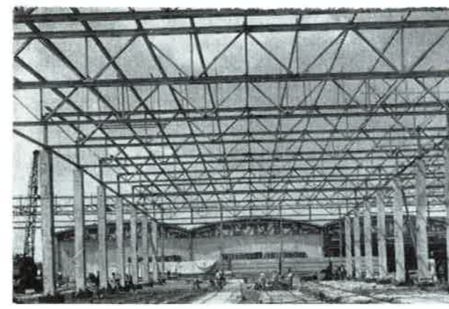
7. ábra. Békéscsabai Hűtőház új hűtőháza
