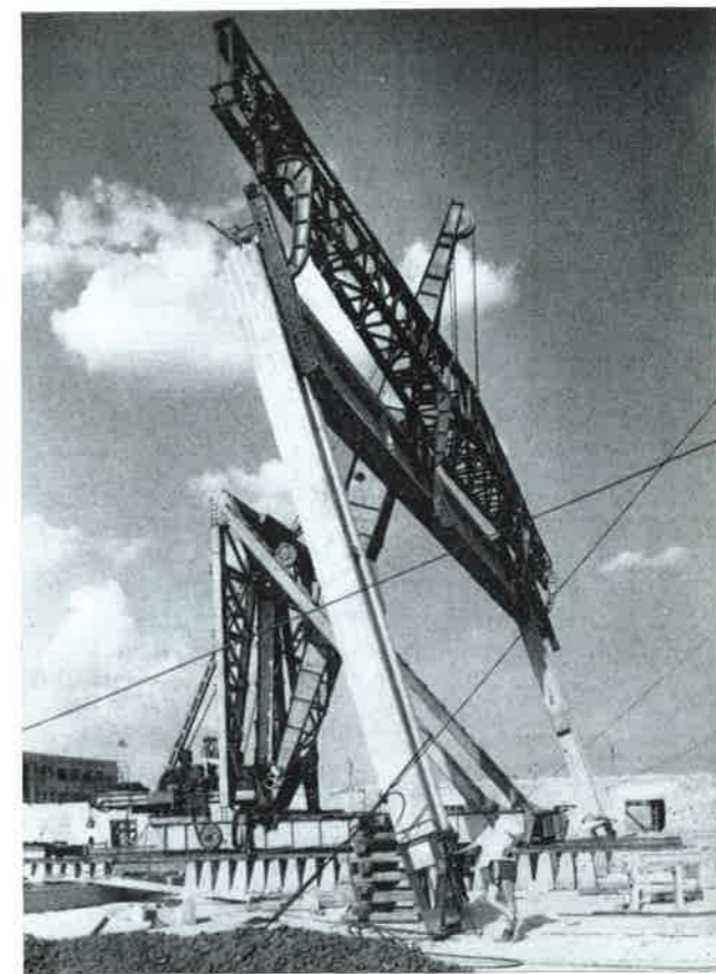
2. ábra. A Gyöngyösi Váltógyár kereteinek beemelése (Mátrai-Pásztai)
