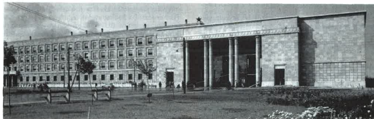
5. ábra. A Dunai Vasmű főbejárati épülete (Szendrői—Lauber)
