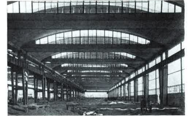
3. ábra. A héjszerkezetű KÖFÉM csarnok
