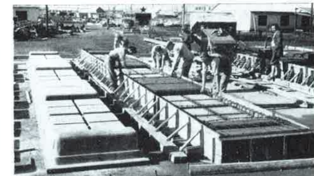
4. ábra. A Dunajvárosi Erőmű tetőpanelének helyszíni előgyártása
