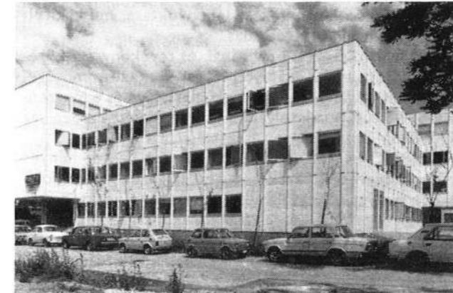
6. ábra. FILLOD szerkezetű irodaház, Budapest
