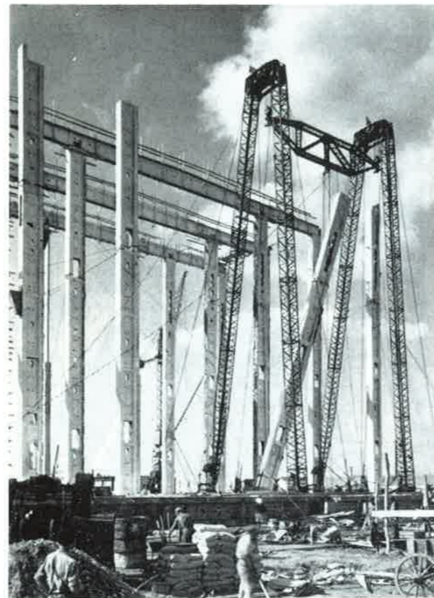
1. ábra. A Borsodi Erőmű pillérének beemelése (Mátrai Gyula)
