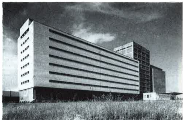
4. ábra. 1500 vagonos gabonátárház, Mezőkövesd
