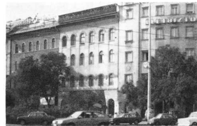
2. ábra. Az Ipari Épülettervező Intézet (ITI) székháza a volt London szálló (1949) Marx-tér
