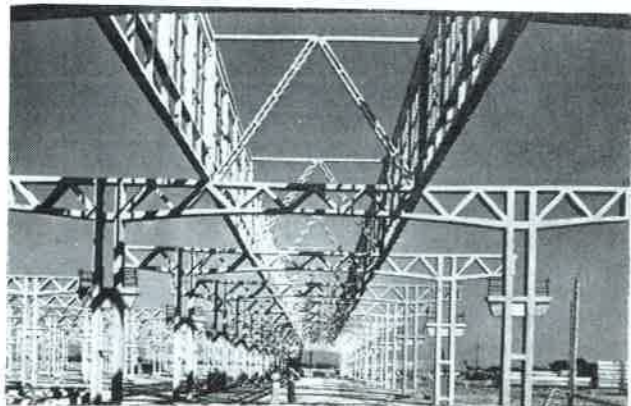
4. ábra. A debreceni GÖCS csarnok laterna felülvilágítói
